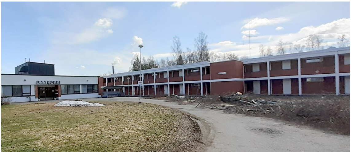
Äänekosken Piilolan asuntolan remontti alkoi puiden kaatamisella 29.4.2021.
