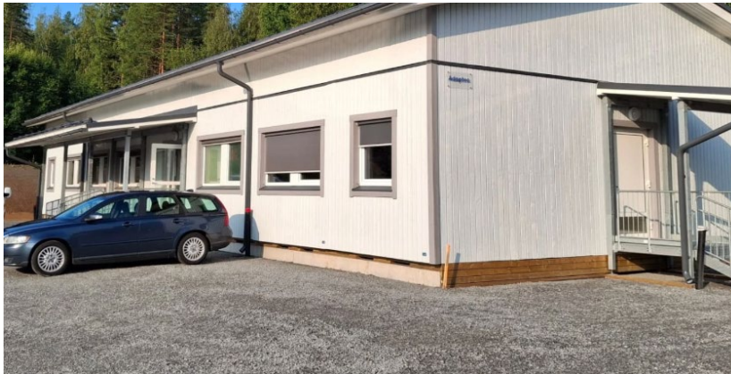
Logistiikka-alan rakennus Laukaan Rokkakankaalla.
