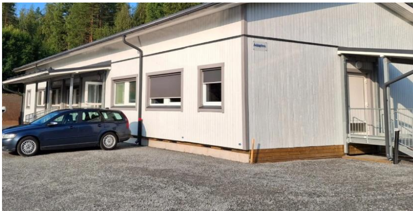
Logistiikka-alan rakennus Laukaan Rokkakankaalla.
